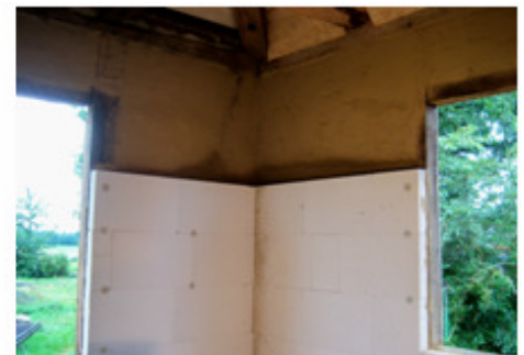
Passtücke der Ytong Multipor Mineraldämmplatte werden mit einem Fuchsschwanz leicht auf die beliebigen Maße zugeschnitten, so dass alles passt, auch an schwierigen Stellen.
