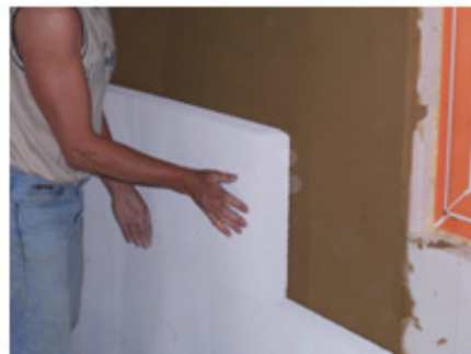
Auf die Wandfläche mit Lehmputz wird die Dämmplatte mit dem erforderlichen Druck eingeschwommen.
