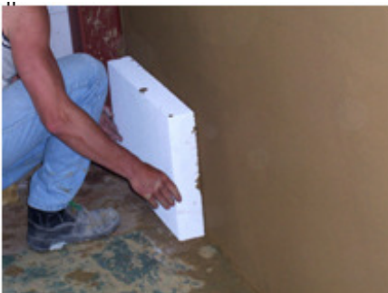
Ytong Multipor Minerale Dämmplatten werden im Fugenversatz mit Lehmputz vollflächig auf den vorbereiteten Untergrund geklebt.
