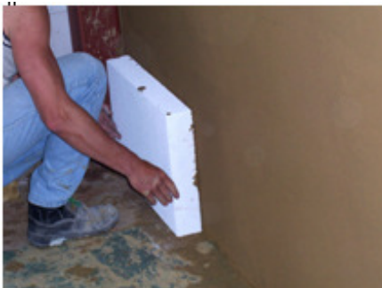
Ytong Multipor Mineraldämmplatten werden im Fugenversatz mit Lehmputz vollflächig auf den vorbereiteten Untergrund geklebt.
